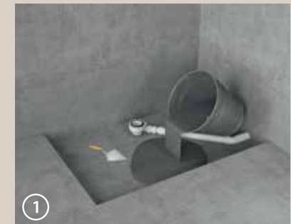
II. Burkolható zuhanytálca beépítése kötőanyaggal kialakított alapra
